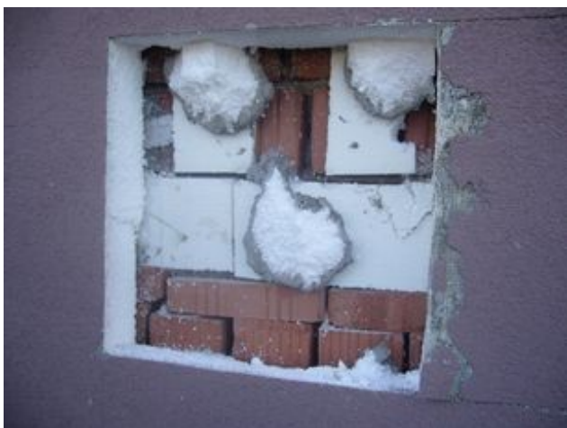
foto/9/ Pohled na vyrovnání podkladu pomocí tepelného izolantu
