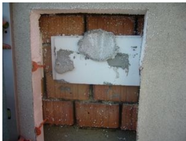
foto/10/ Pohled na vyrovnání podkladu pomocí tepelného izolantu
