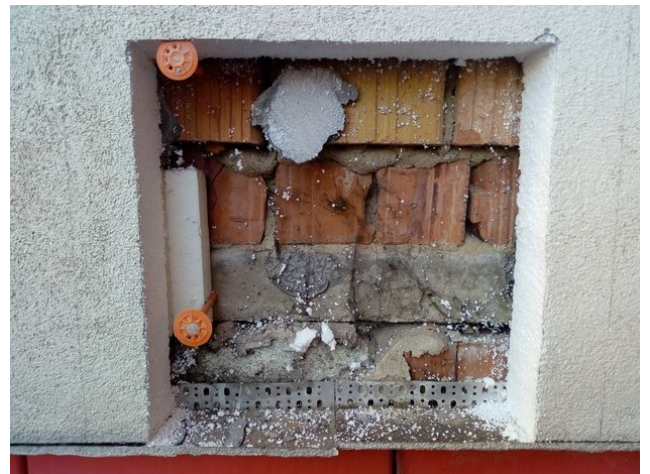
foto/14/ Pohled na princip lepení tepelného izolantu
