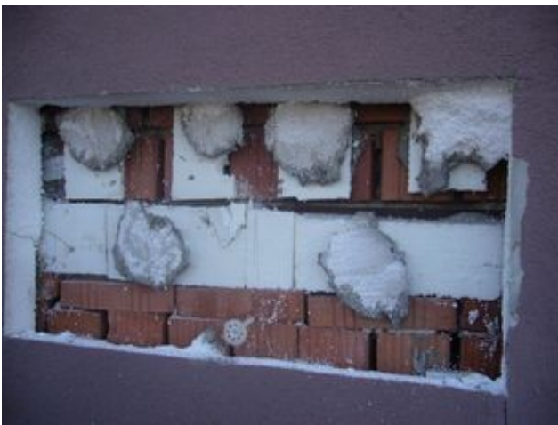
foto/1/ Pohled na provedenou sondu S1
