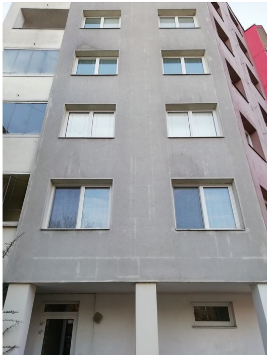
foto/37/ Pohled na prokreslování spár tepelného izolantu a talířů hmoždinek
