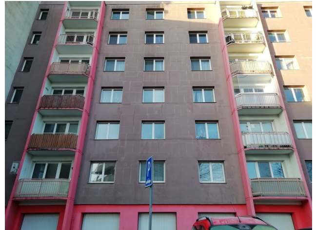
foto/36/ Pohled na prokreslování spár tepelného izolantu a talířů hmoždinek
