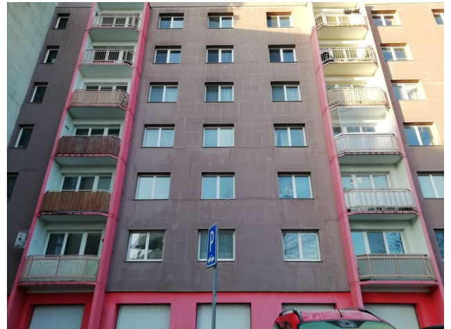
foto/12/ Pohled na prokreslování spár tepelného izolantu a jeho patrné vazby
