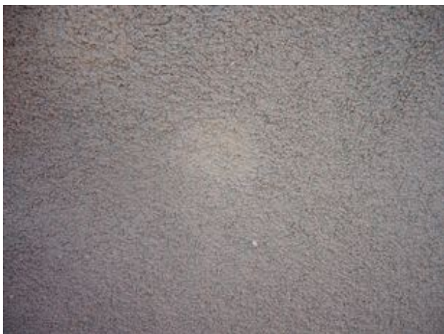
foto/21/ Pohled na povrchovou úpravu ETICS
