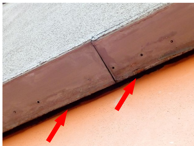
foto/32/ Pohled na spáru mezi základacím profilem a podkladem
