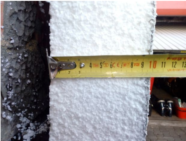
foto/11/ Pohled na tloušťku tepelného izolantu
