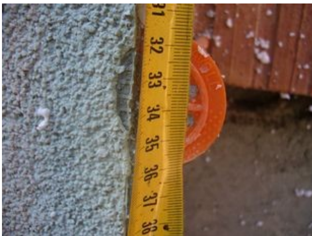
foto/17/ Pohled na průměr talíře hmoždinky
