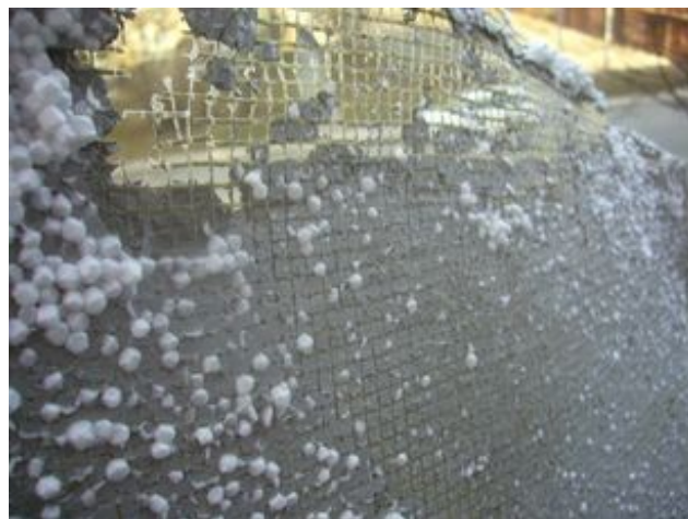
foto/22/ Pohled na výztužnou tkaninu vtačenou do jedné vrstvy základní vrstvy
