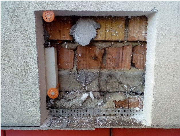
foto/5/ Pohled na provedenou sondu S3
