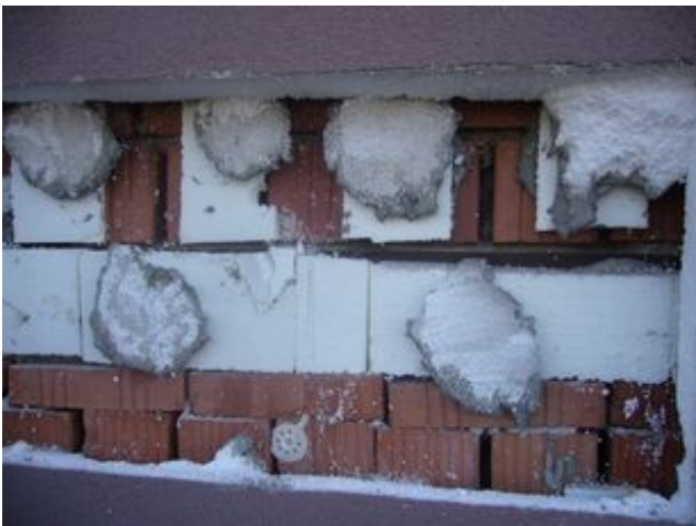
foto/13/ Pohled na princip lepení tepelného izolantu
