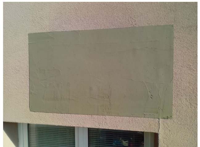
foto/2/ Pohled na zapravenou sondu S1
