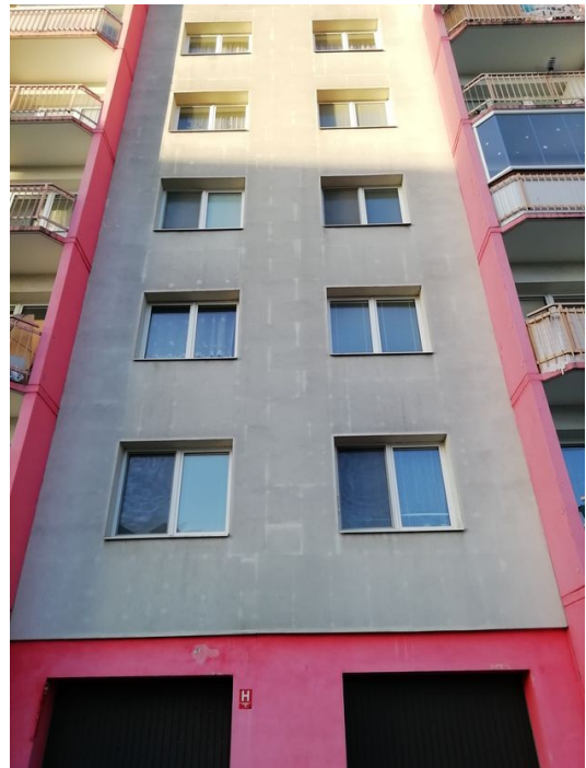
foto/38/ Pohled na prokreslování spár tepelného izolantu a talířů hmoždinek
