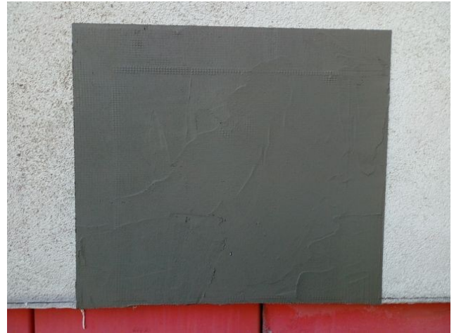
foto/6/ Pohled na zapravenou sondu S3
