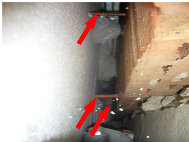
foto/16/ Pohled na umístění kotevního prvku mimo terče
