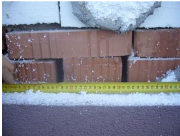
foto/8/ Pohled na spáry mezi jednotlivými tvarovkami
