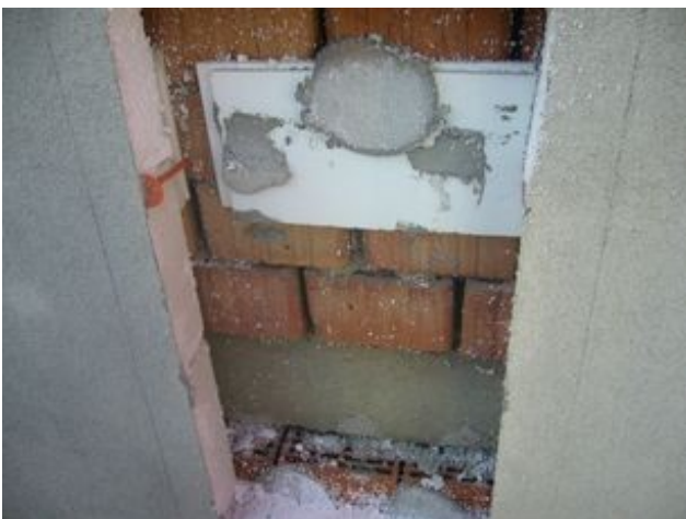
foto/3/ Pohled na provedenou sondu S2
