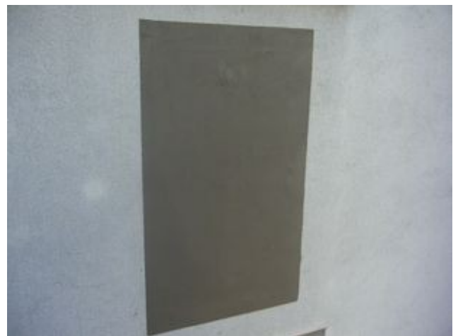
foto/4/ Pohled na zapravenou sondu S2
